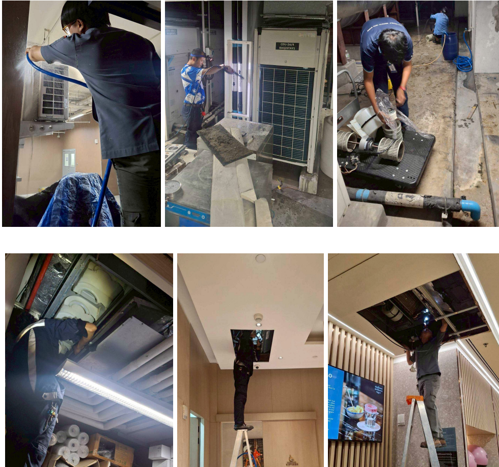
ภาพที่ 3-44 ล้างทำความสะอาดเครื่องปรับอากาศส่วนกลางประจำอาคาร
