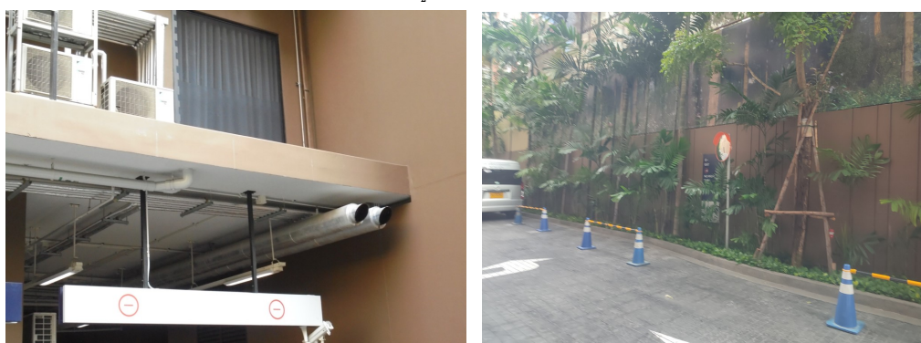
ภาพที่ 3-17 ท่อไอเสียจากห้องไฟฟ้าถูกเงิน ปลอຍออกมาตรงกับต้นไม้ยืนต้นข้างรั้วโครงการ
