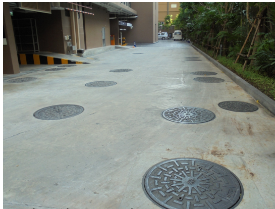
ภาพที่ 3-8 พื้นที่ติดตั้งระบบบำบัดน้ำเสียซึ่งอยู่ใต้ทางวิ่งรถด้านทิศตะวันตก
